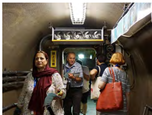
下水道管内(小川幹線)の見学
